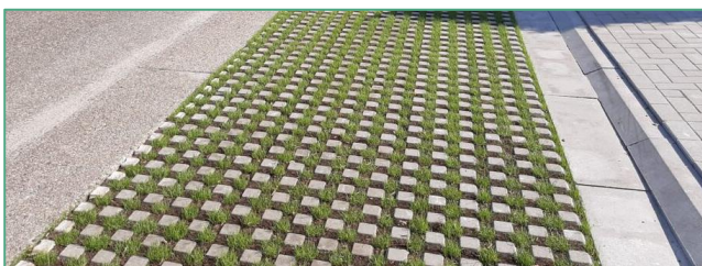
Afbeelding 4.2 voorbeeld waterdoorlatende verharding
