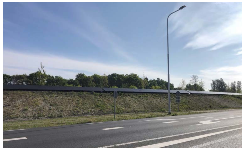
Voorbeeld zonnepanelen op geluidwal (locatie: N303 Voorthuizen)
