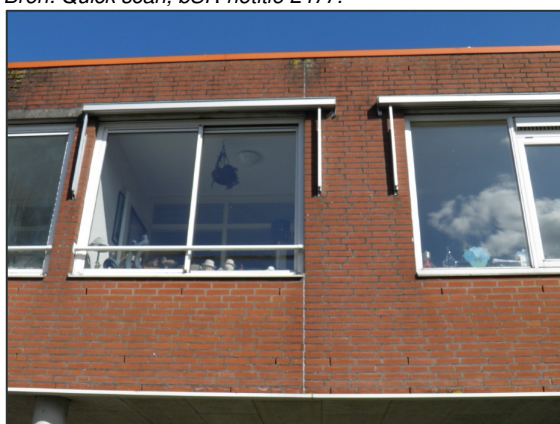
Afbeelding 6: Het hoofdgebouw beschikt over stootvoegen. Bron: Quick scan, bSR-notitie 2477.
