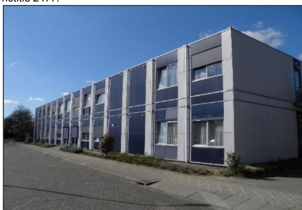
Afbeelding 4: Tijdelijke uitbreiding, opgebouwd uit Portakabins. Bron: Quick scan, bSR-notitie 2477.
