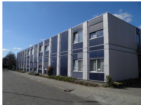
Figuur 5. Tijdelijke uitbreidingslocatie van de zorgwoningen.
