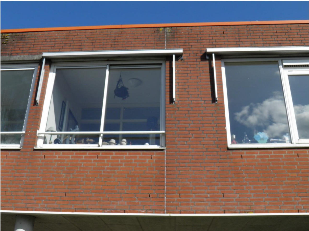
Figuur 11. Open stootvoegen bieden kleine vleermuissoorten toegang tot de spouwruijnte in de gevels.
