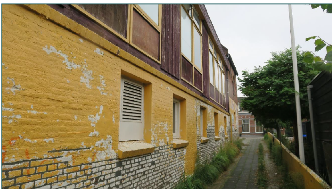
Figuur 2 De bebouwing bestaat uit gemetselde muren of houten wanden met grotendeels platte daken en 2 gebouwen met een dakpannen bedekt zadeldak.
