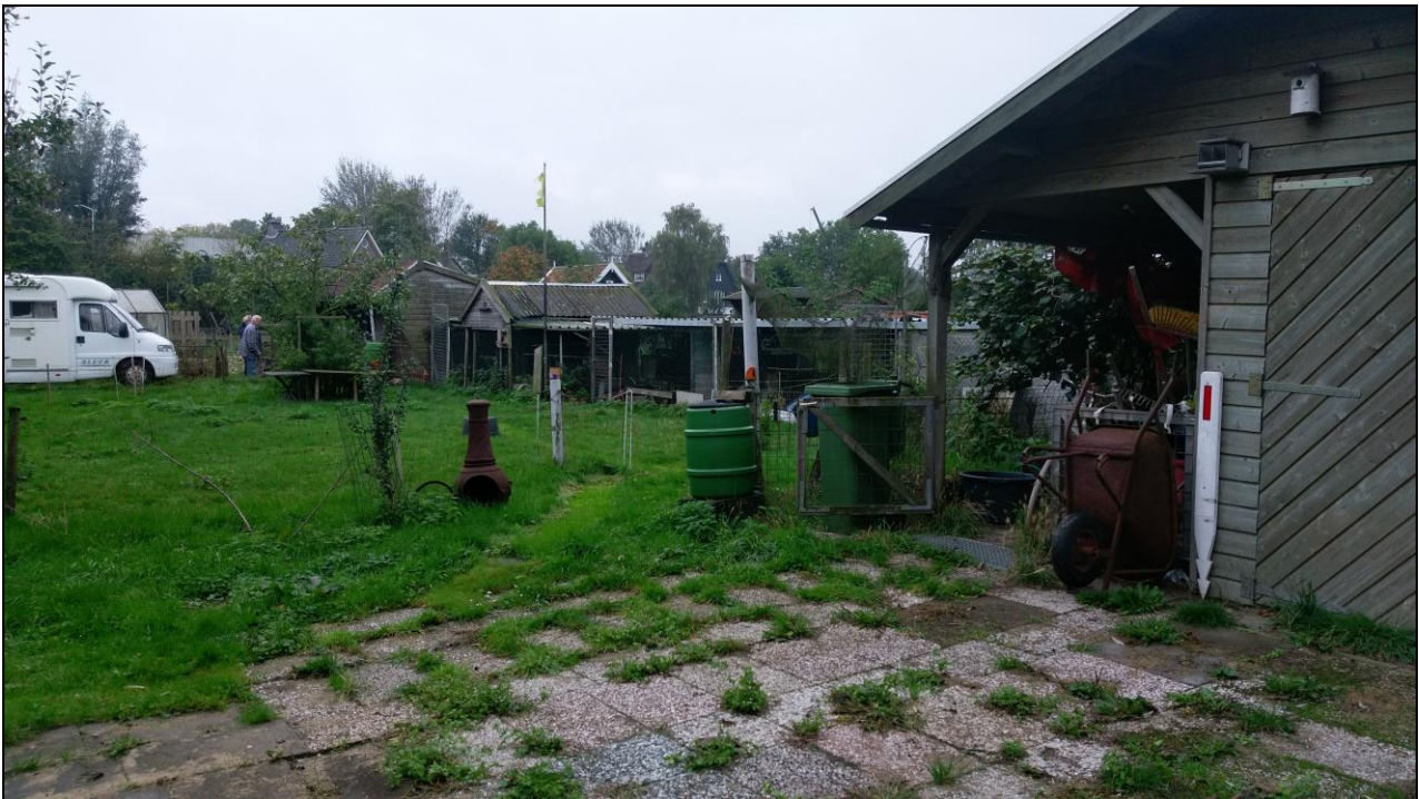
Figuur 6a: het plangebied tijdens de werkzaamheden in zuidwestelijke richting gefotografeerd.
