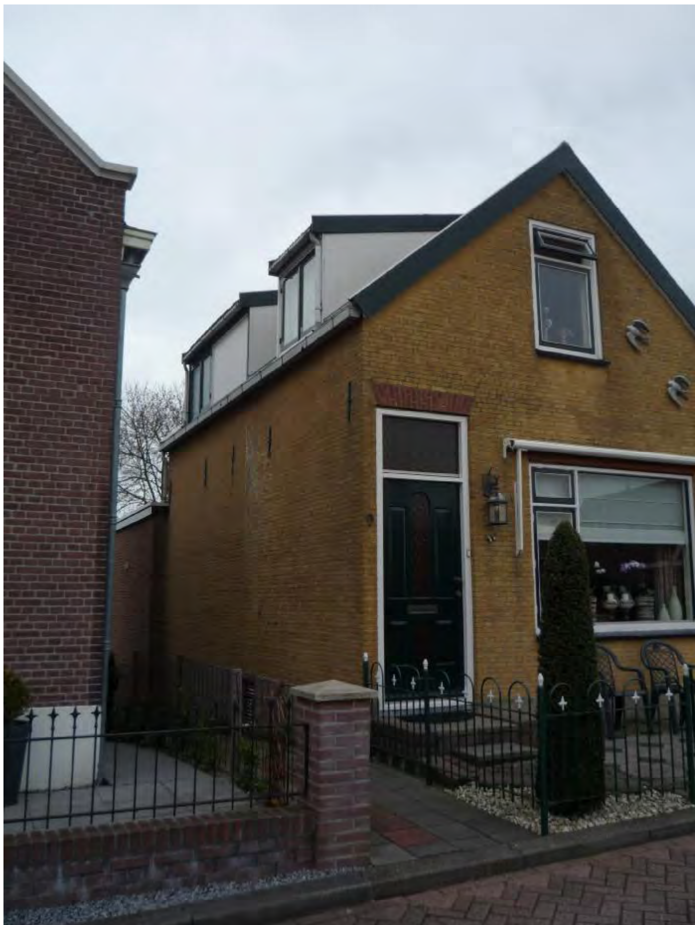
Damstraat 9 linker zijgevel (2)
