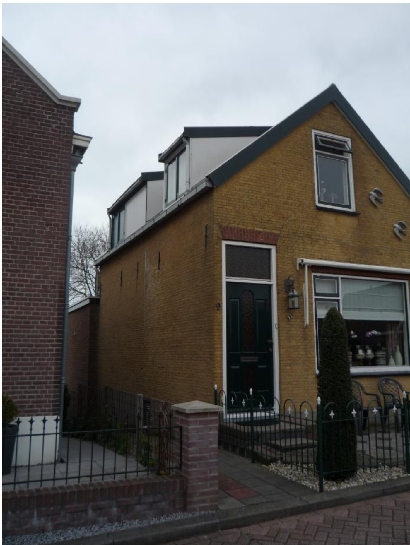
Damstraat 9 linker zijgevel (2)
