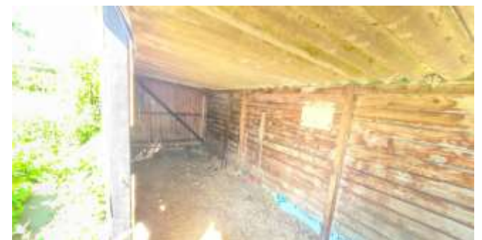
Figuur 9: Binnenkant schuur
