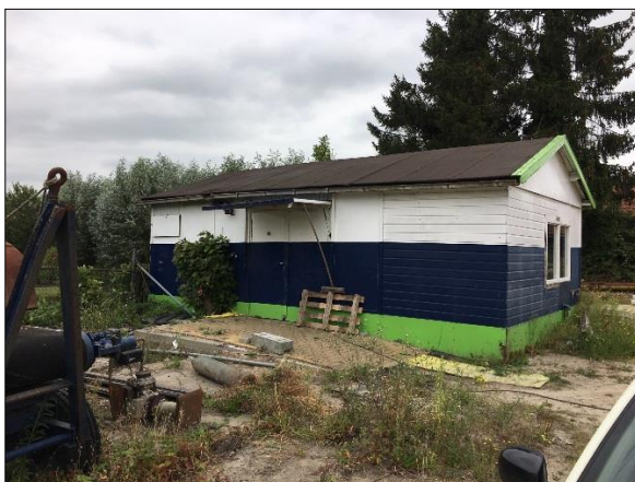
Figuur 6. Westzijde gebouw
