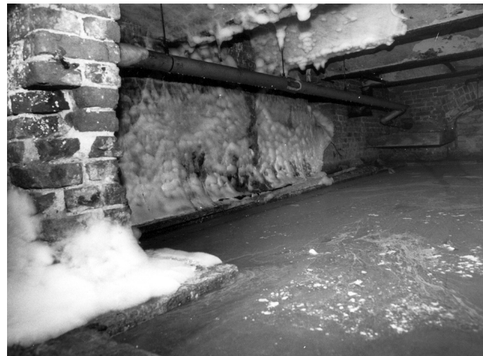
Foto 2 Schimmelvorming als gevolg van grondwateroverlast 1
