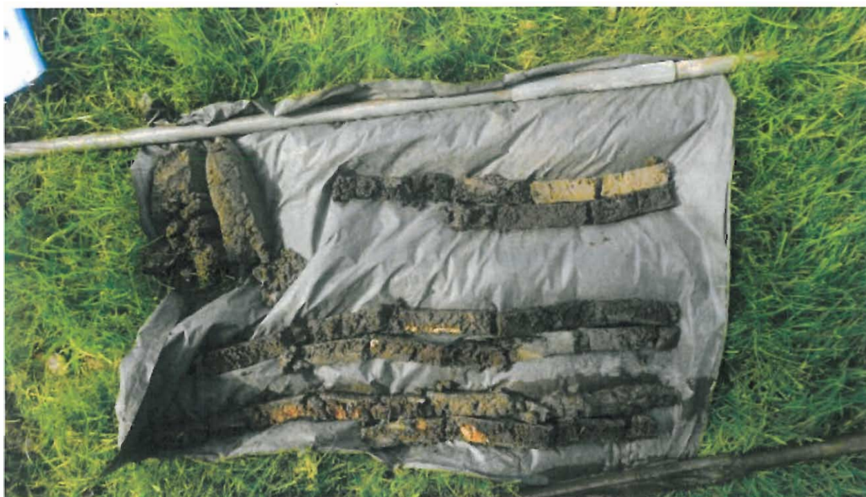
Boring 7: Opname boorkernen en gutskernen.
