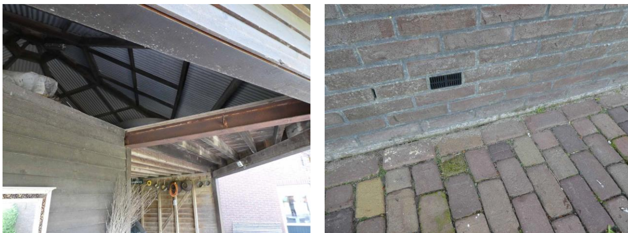
Figuur 10: Links: Binnenzijde van de hooitas (1) en rechts: stootvoeg en ventilatie in schuur (2)
