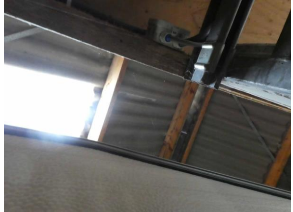
Figuur 16 Zicht op dakconstructie binnenzijde, veel lichtinval
