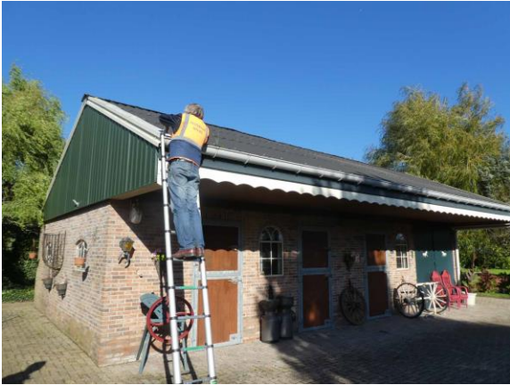
Figuur 14 Inspectie dak golfplaten
