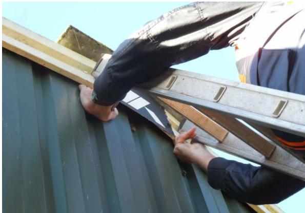
Figuur 11 Inspectie damwandprofielplaten
