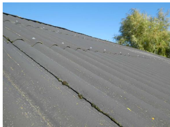
Figuur 8 Dak met golfplaten
