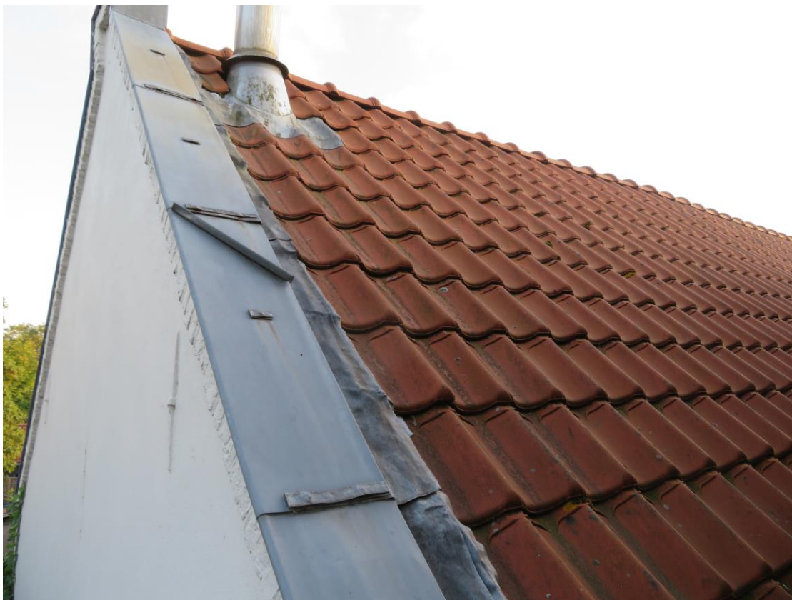
Daklijst en loodslabben sluiten goed aan
