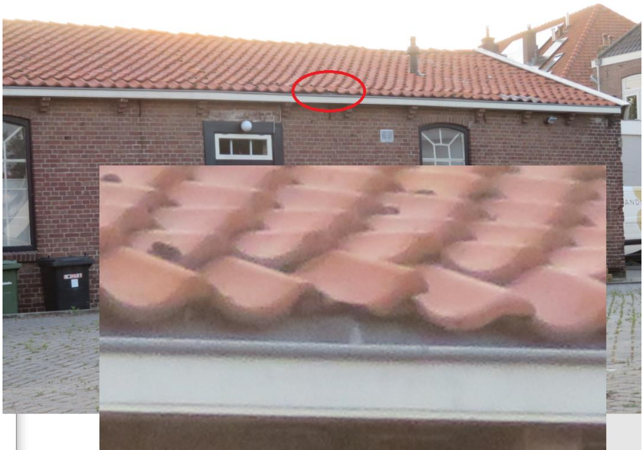
Bij de schuur wijkt 1 pan in de dakgoot iets af van de rest. Op de close-up is te zien dat deze geen toegang tot een achterliggende ruimte geeft. De foto geeft ook aan dat de rest van de dakpannen goed aansluit.
