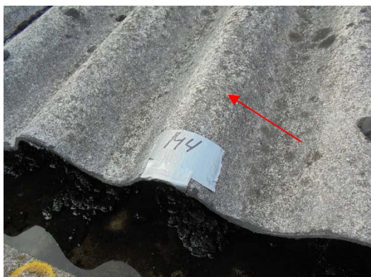
Foto 1 – bron 01, ML 04 plaatmateriaal (golfplaat)
