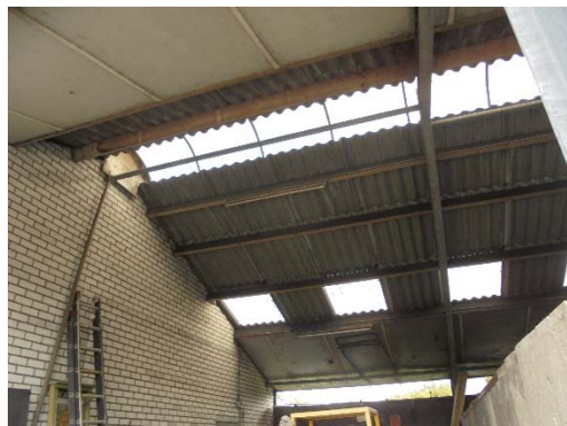
Foto – asbestvrije golfplaat Wagenstal
