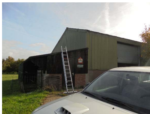
Foto – asbestvrije golfplaat
