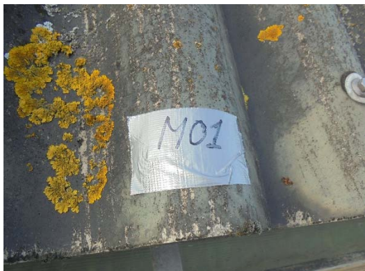
Foto – asbestvrije golfplaat Wagenstal
