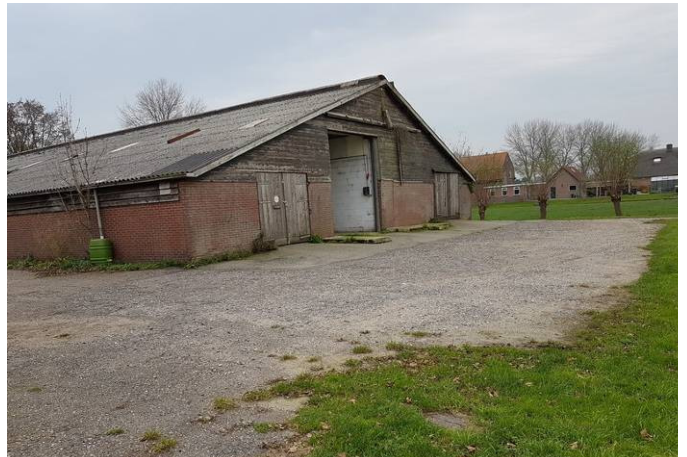
Foto 2: noordwestzijde locatie / ligboxenstal (vanaf noordoostzijde)
