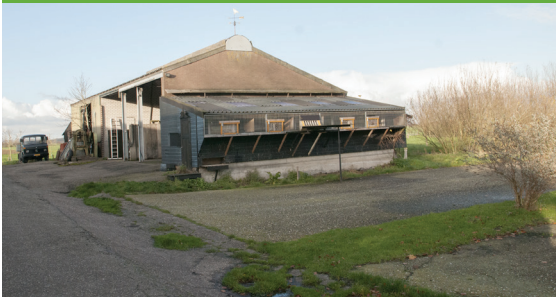
Diverse aanbouwen aan de loods.
