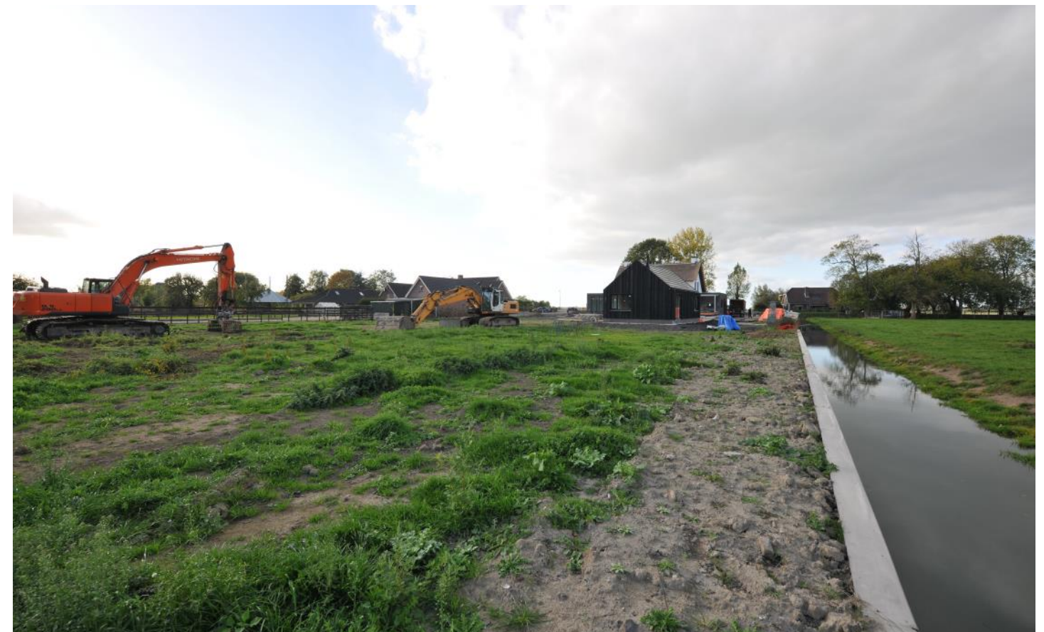
5. Achterzijde schuur en woning vanaf erf
