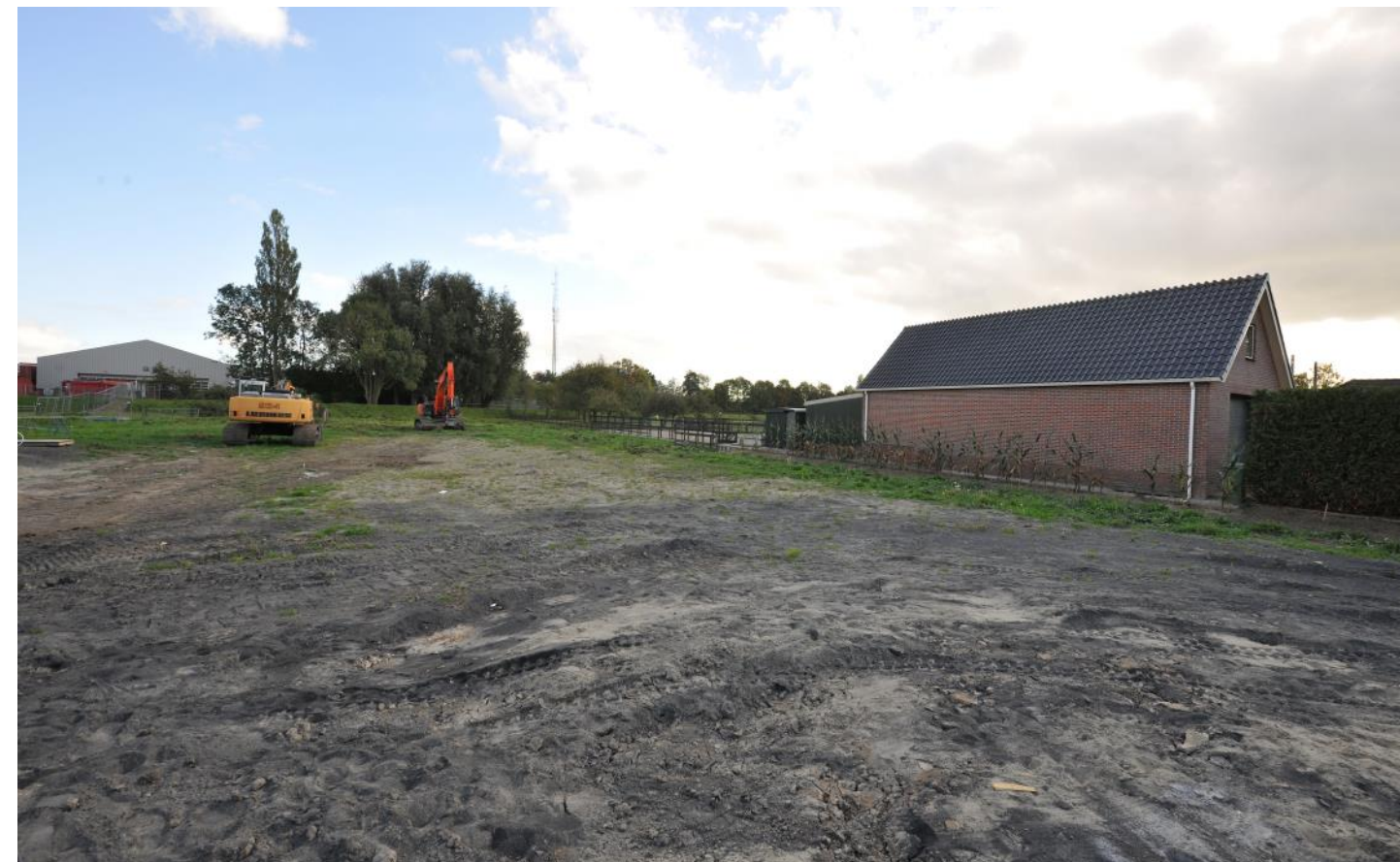
5. Zicht op schuur van buren en achterzijde terrein (zuid oostelijke richting)
