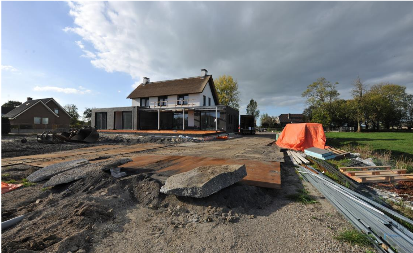
3. Achterzijde van de woning
