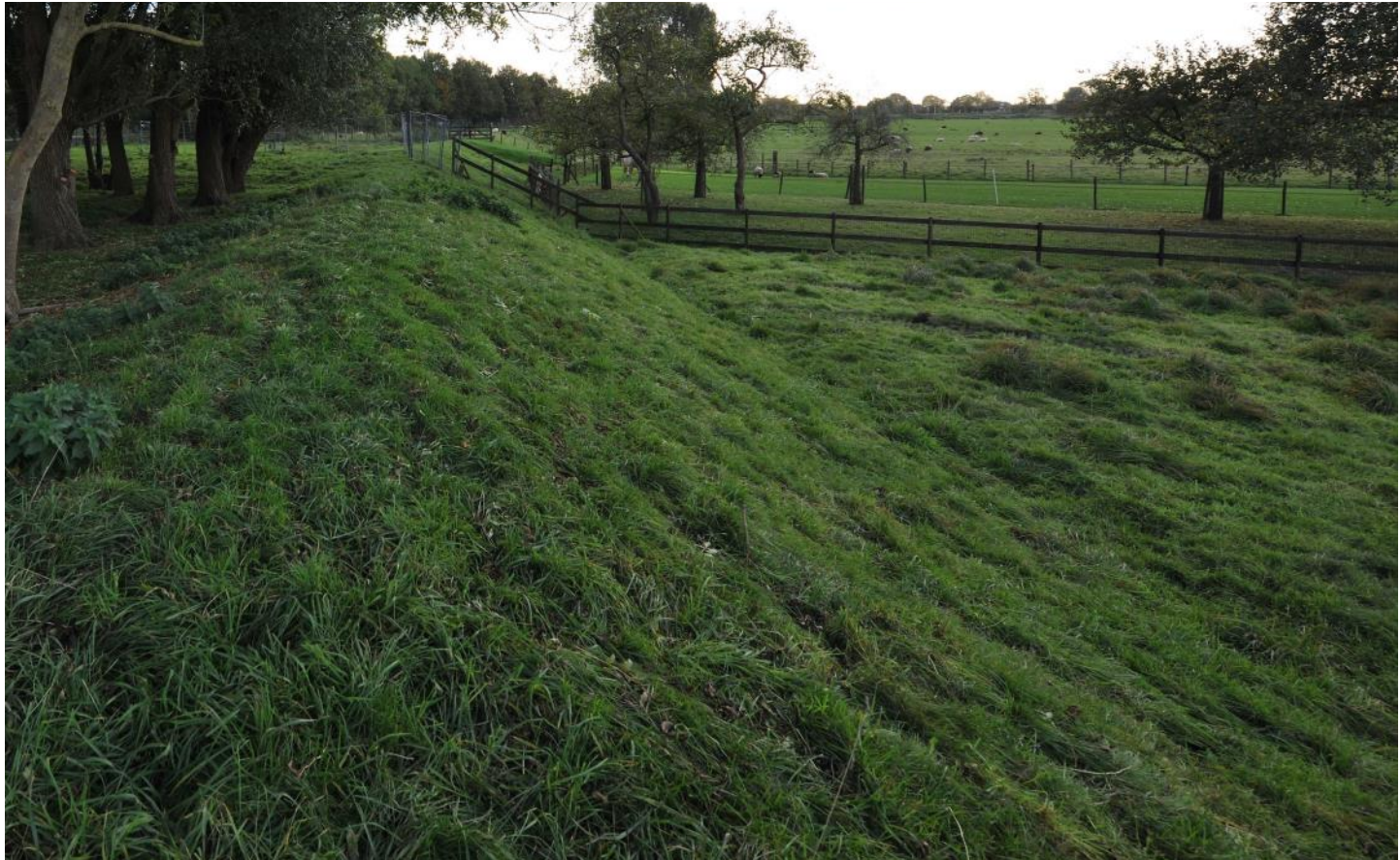
1. Zicht op achterzijde van het terrein richting erf van zuidwestelijke burens. Incl. verhoogde waterkering.
