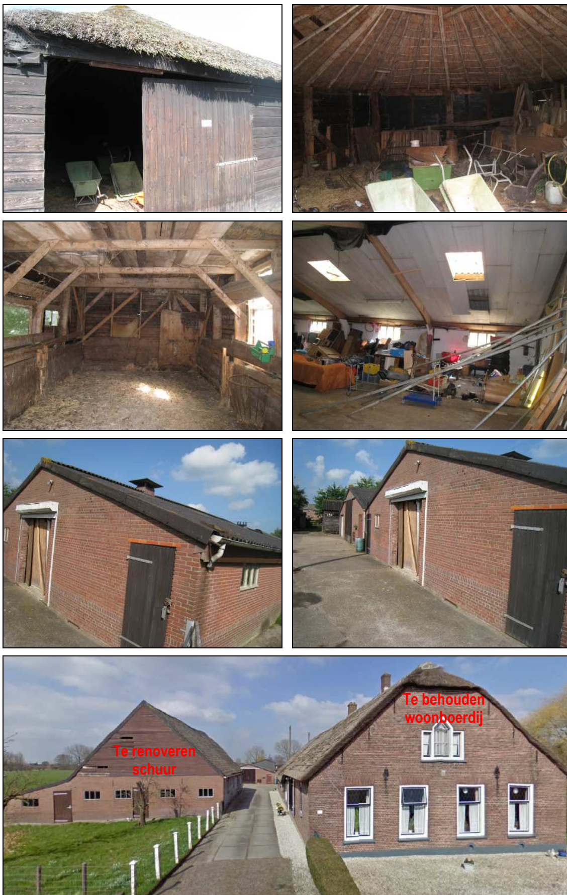
Figuur 2. Aanzicht van de te slopen opstallen (bovenste zes foto's) en te behouden woonboerderij met te renoveren schuur Willeskop 160 te Oudewater.
