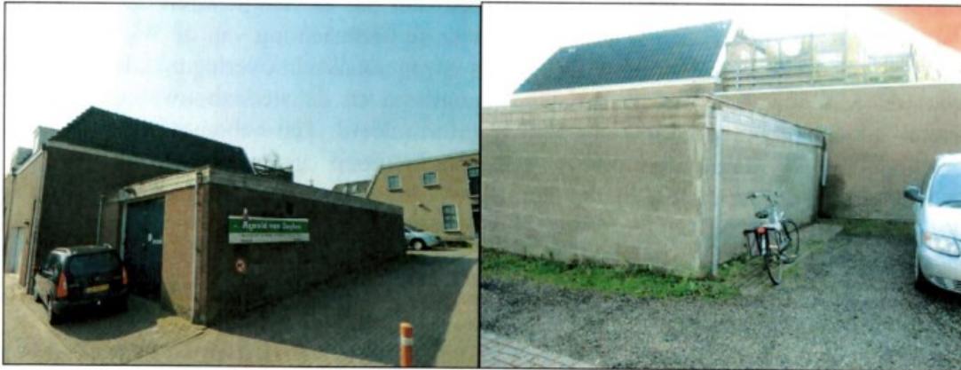
Wijngaardstraat ter hoogte van de bouwlocatie
