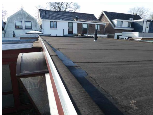
Figuur 12: Het dak van de woning
