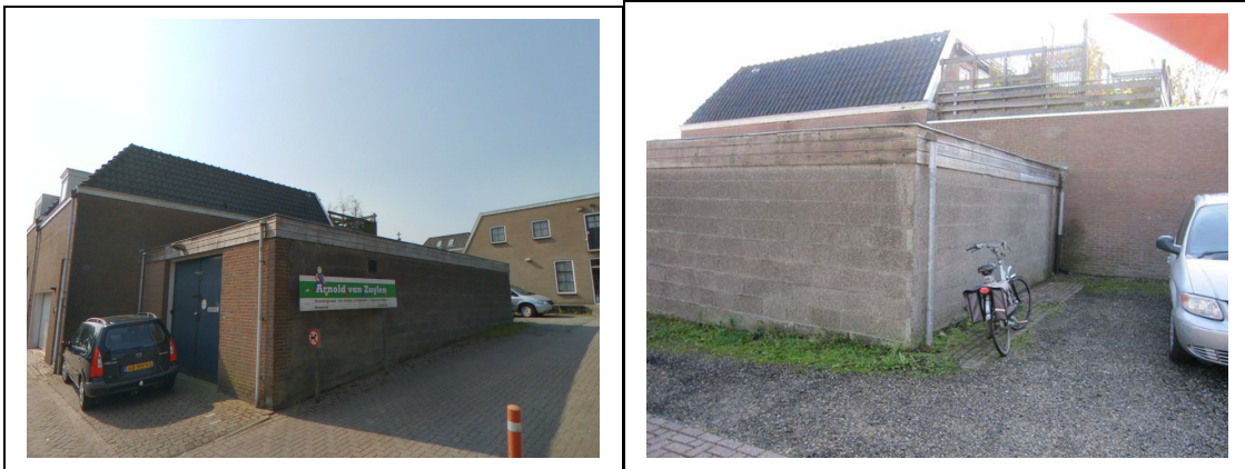
Wijngaardstraat ter hoogte van de bouwlocatie
