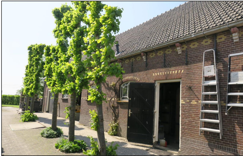
Figuur 7 De zuidzijde van de schuur is voorzien van stormpannen. Tevens zijn er geen openingen, zoals ventilatieroosters en open stootvoegen, in de muren aanwezig. Er zijn geen kieren rondom raam- en deurkozijnen aanwezig.
