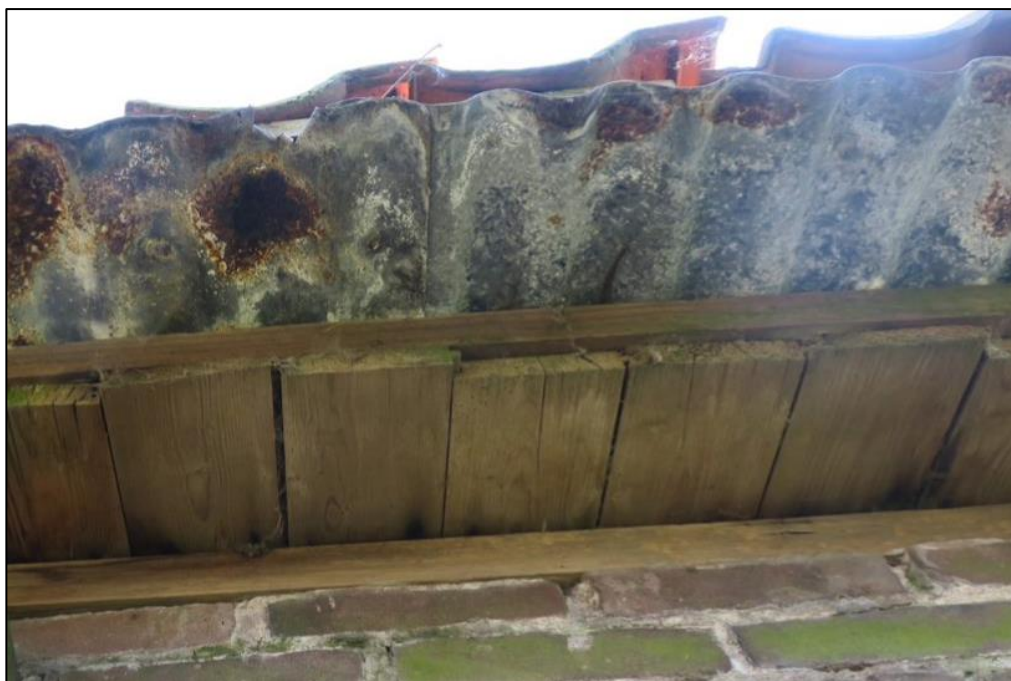
Figuur 9 De noordzijde van de schuur. Het dak is van de onderzijde afgetimmerd met hout waardoor er niet aangevlogen kan worden op de horizontale muur om een opening te bereiken. De houten betimmering sluit strak aan.
