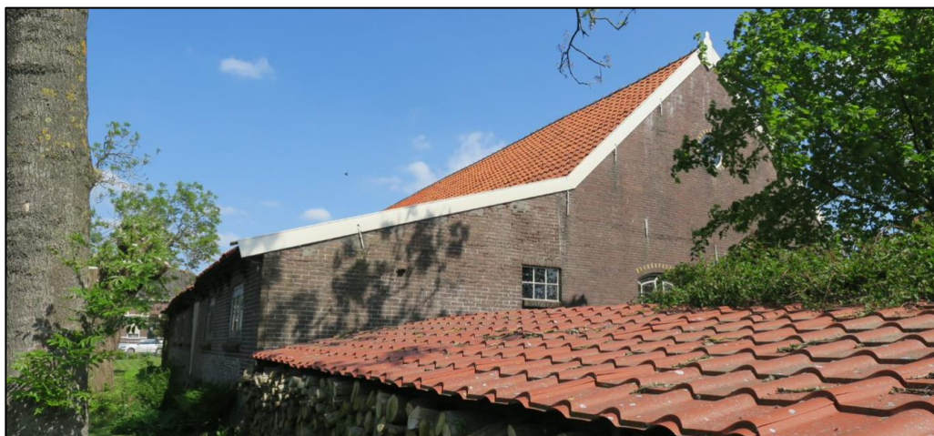
Figuur 8 De noordzijde van de schuur betreft een aangekapt dak met helling. De daklijsten sluiten strak aan.
