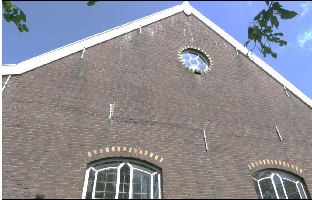
Figuur 5 De muren van de schuur bevatten geen ventilatieroosters, open stootvoegen of andere openingen of kieren die toegang kunnen verlenen tot een open spouwruimte. Tevens sluiten de daklijsten strak aan op de bebouwing, waardoor deze ook niet fungeren als invliegopening voor vleermuizen.
