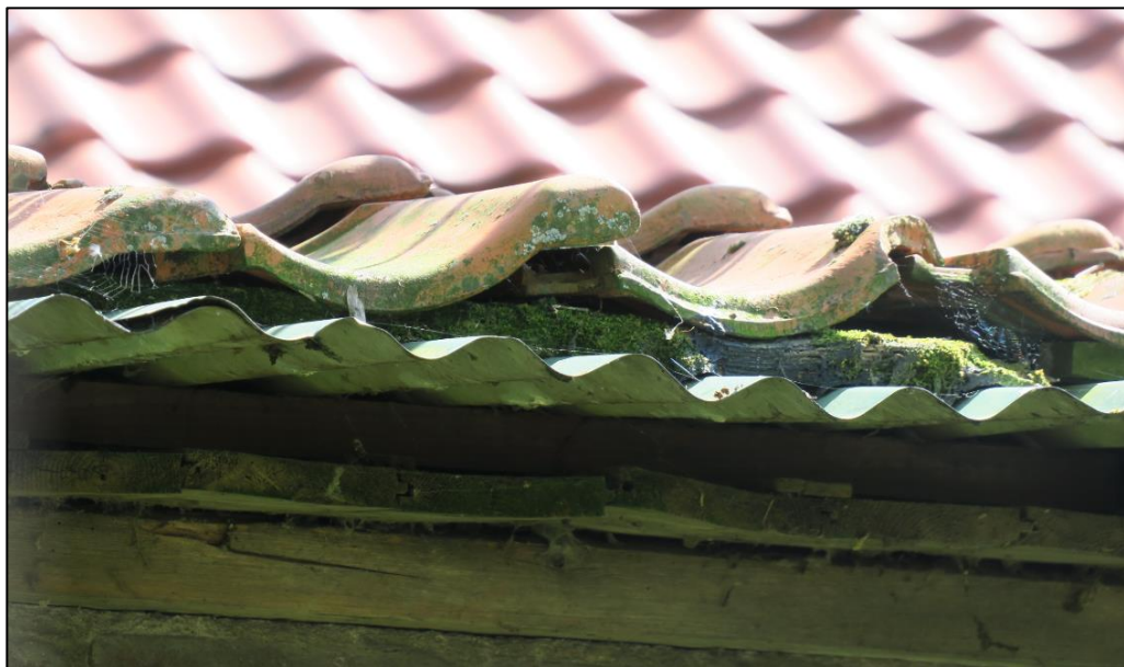
Figuur 11 Visuele representatie van het aangekapte dak. De dakconstructie bestaat uit golvende dakpannen waaronder metalen golfplaten en houten latten zijn aangebracht.
