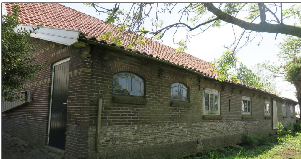
Figuur 10 Visuele representatie van het aangekapte dak (noordzijde schuur). De dakconstructie bestaat uit golvende dakpannen waaronder metalen golfplaten en houten latten zijn aangebracht.
