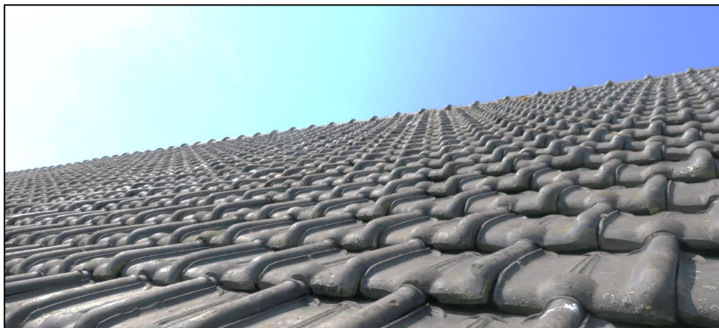
Figuur 6 De zuidzijde van de schuur is voorzien van stormpannen. Deze pannen sluiten strak op elkaar aan.
