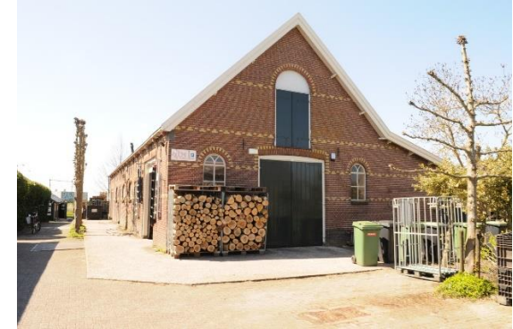
3. Voorkant schuur en opslagterrein
