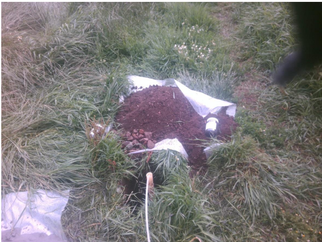
Foto asbestinspectiegat B01
