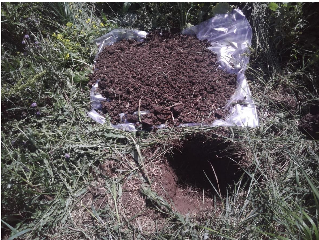
Foto asbestinspectiegat A04
