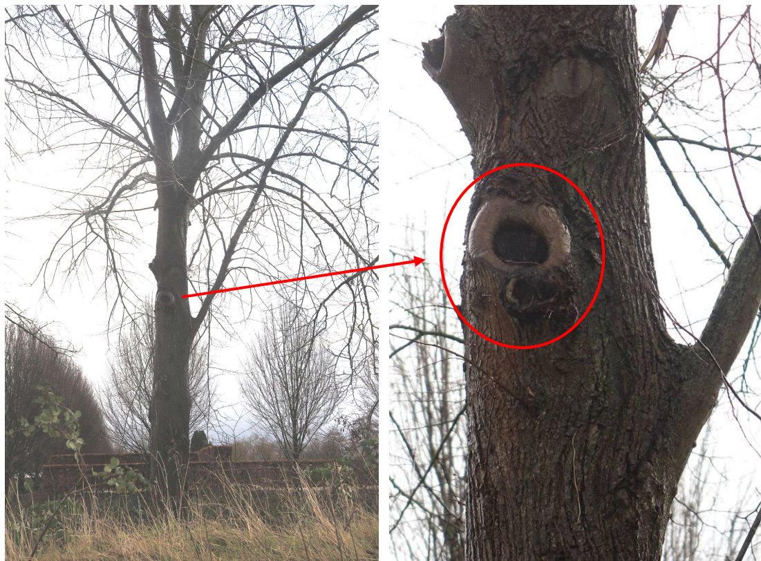
Figuur 4. Openingen in de bomen aan de Sint Janstraat te Oudewater waarin verblijfplaatsen kunnen zitten van vleermuizen.
