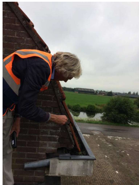
Figuur 13 Inspectie dak
