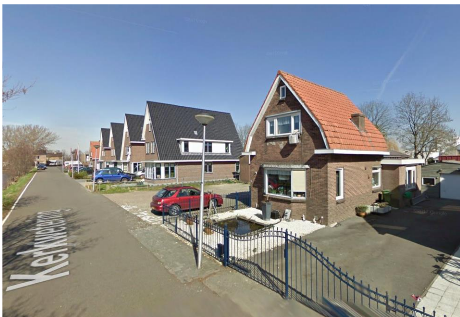
Figuur 2.2: Foto's bestaande situatie – Bron: Google streetview maart 2009
