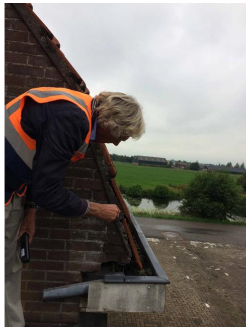
Figuur 13 Inspectie dak
