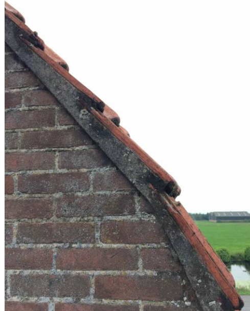
Figuur 12 Zijaanzicht dakpannen woning 13
