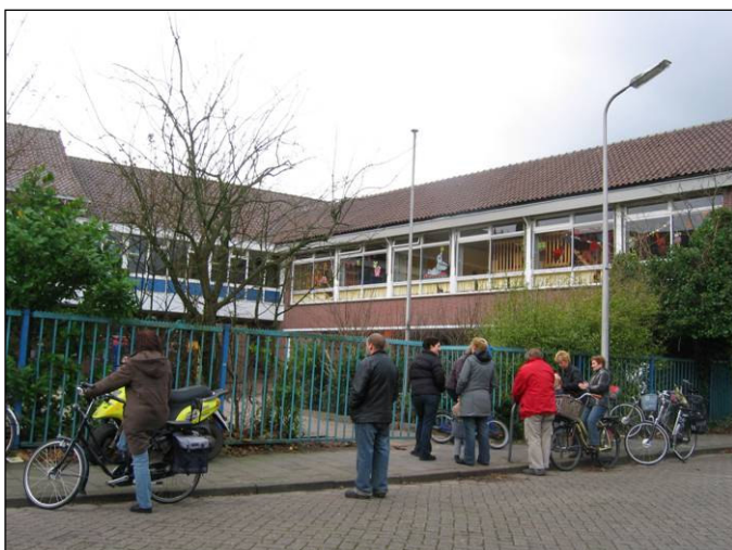
Schoolplein aan de Hendrik van Viandenstraat
