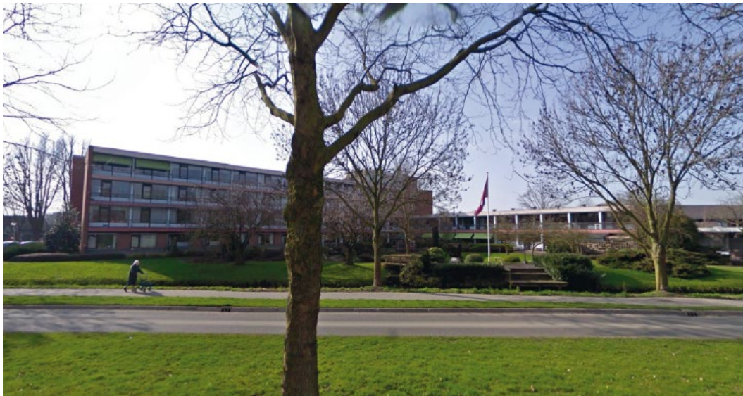
Het gebouw Schuylenburcht voor de sloop (bron: Van Hoogevest Architecten)
