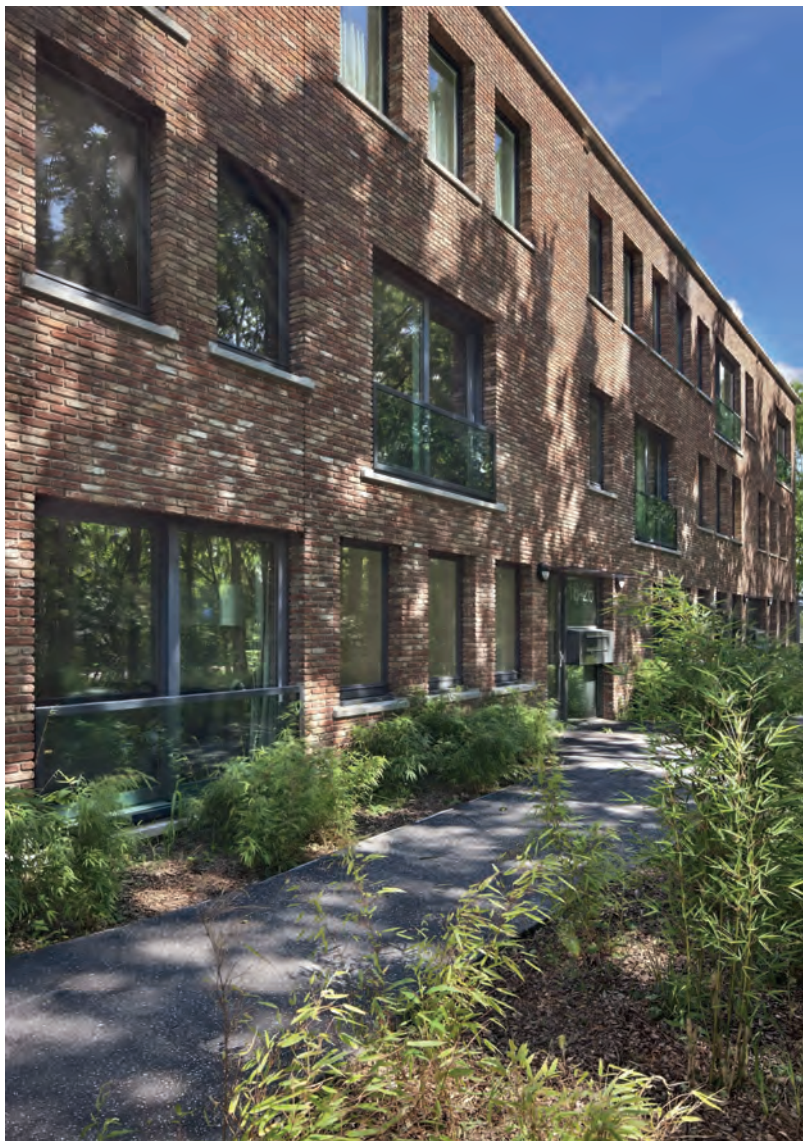
baksteen gevel met beplating tot aan het gebouw
