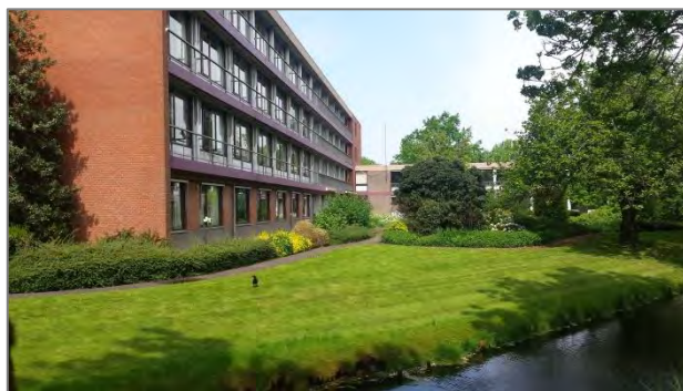
Afbeelding 2.2 | De oostelijke gevel.
