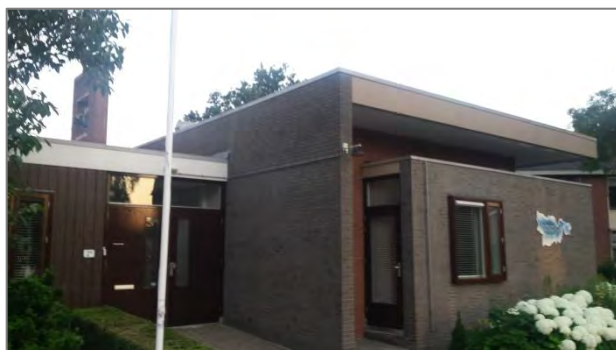
Afbeelding 3.6 | De uitbouw aan de noordzijde van het complex.
