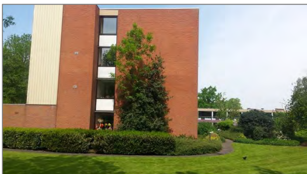
Afbeelding 3.5 | De kopgevel met liftschacht gezien vanaf de Johan J. Vierbergenweg.
