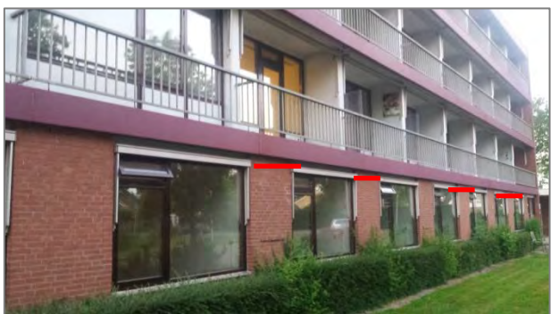
Afbeelding 5.3 | De langsgevel aan de westzijde met in rood aangegeven de plekken waar overdag de gewone dwergvleermuizen slapend zijn te zien, zie ook afbeelding 5.4 & 5.5.
