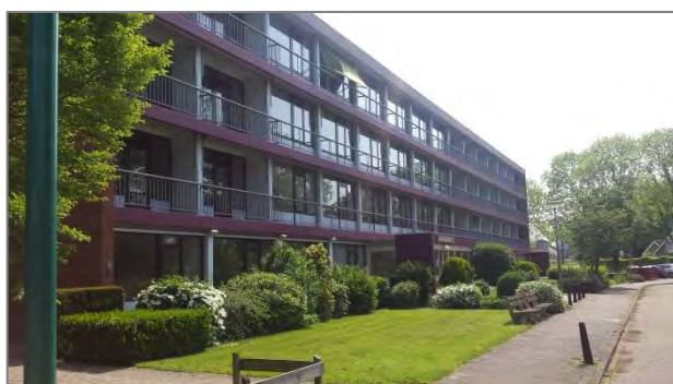
Afbeelding 3.4 | Zicht op de entreezijde (westelijke langsgewel)
