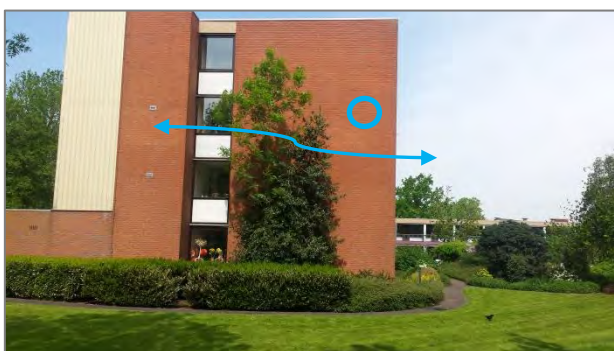
Afbeelding 5.6 | De kopgevel waar de gewone dwergvleermuis baltzend is waargenomen. De blauwe cirkel geeft de paarverblijfplaats aan.
