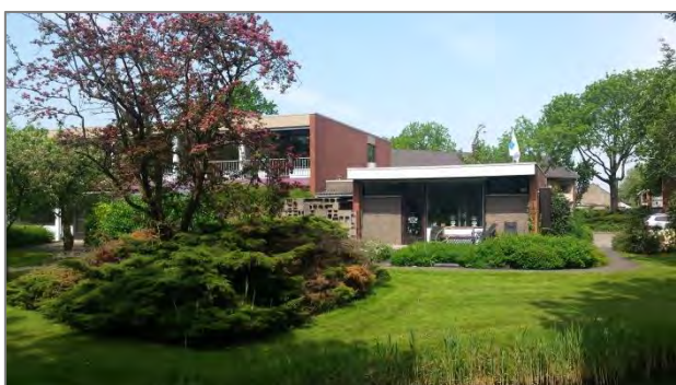
Afbeelding 3.3 | De noordelijke kopgevel
