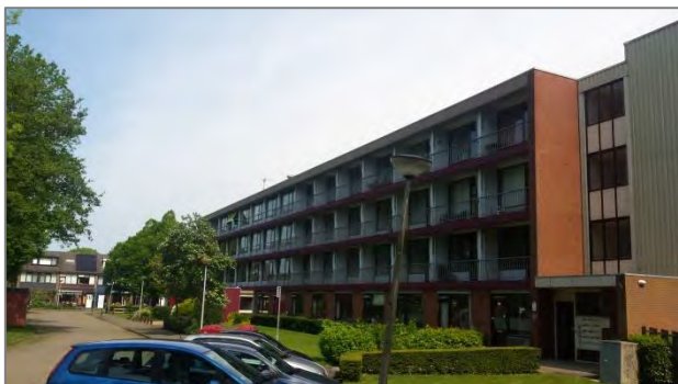
Afbeelding 3.1 | De westelijke langsgevel
