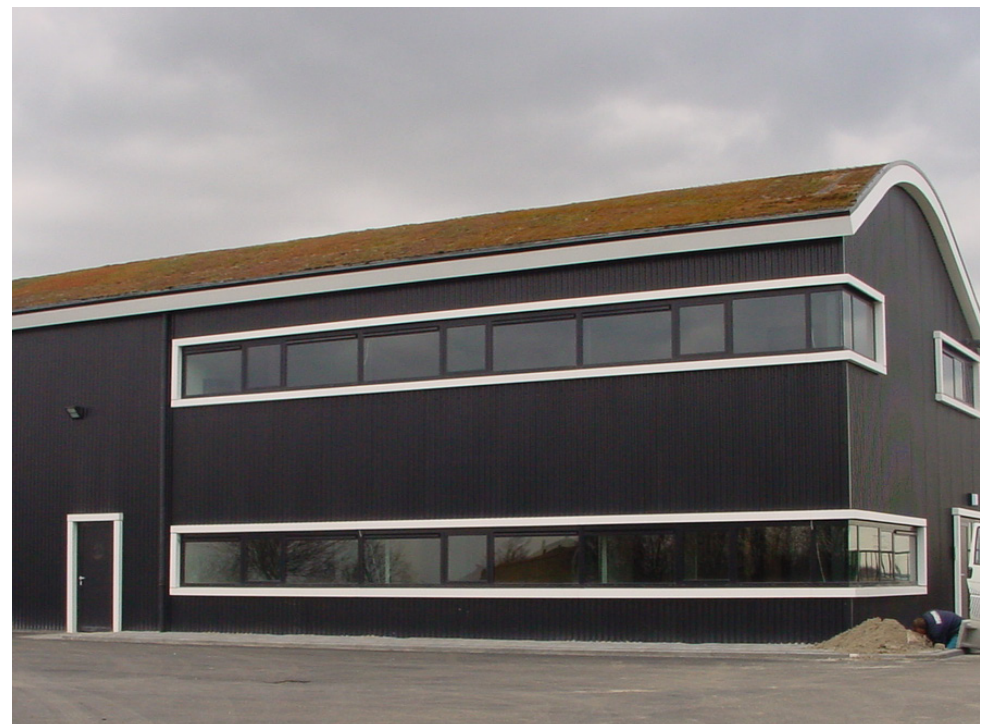
Referentie gemeentewerf Binnenmaas: een moderne loods in streekeigen kleurstelling met een vegetatiedak van sedum. Bron: RoosRos Architecten.
