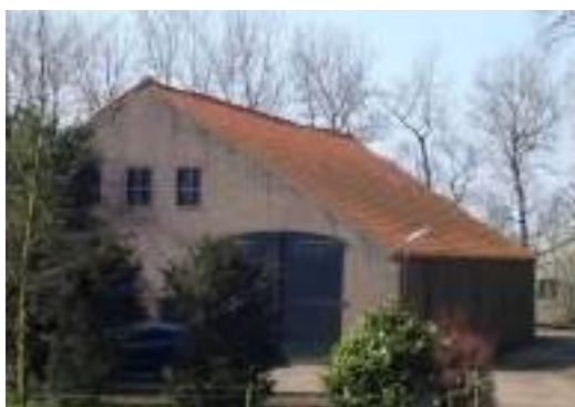
Afbeelding 12 - dakvlakken zijn bepalend in het beeld.
