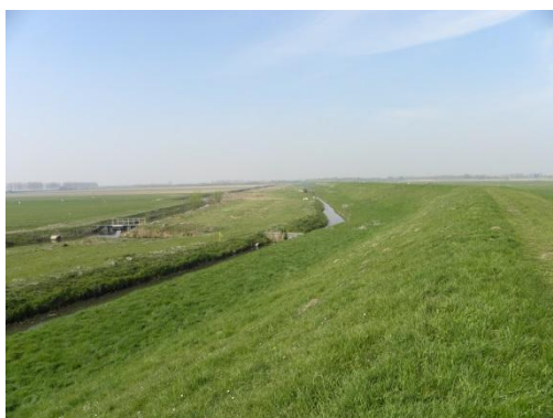
Gorsdijk (oostelijk deel)
