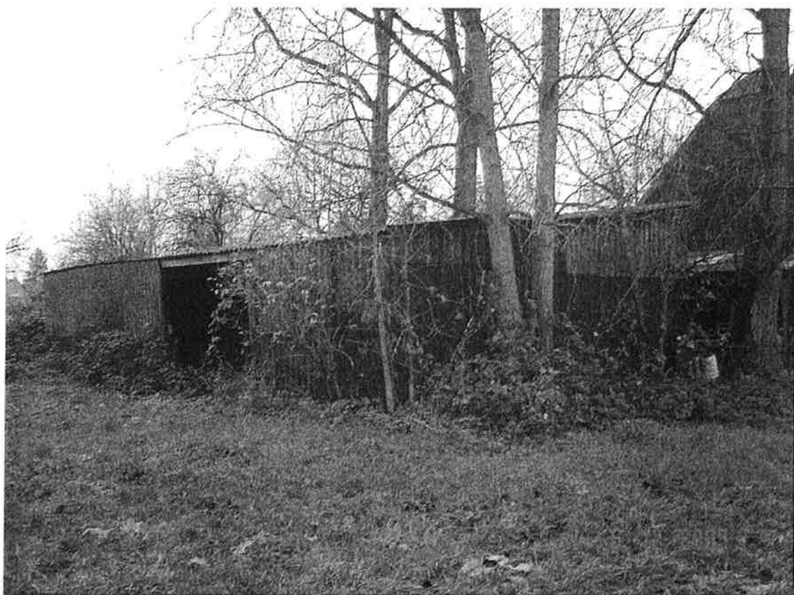
foto 5: stal van asbestverdacht materiaal
