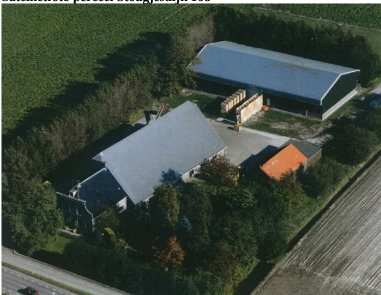
Foto huidige bebouwing
