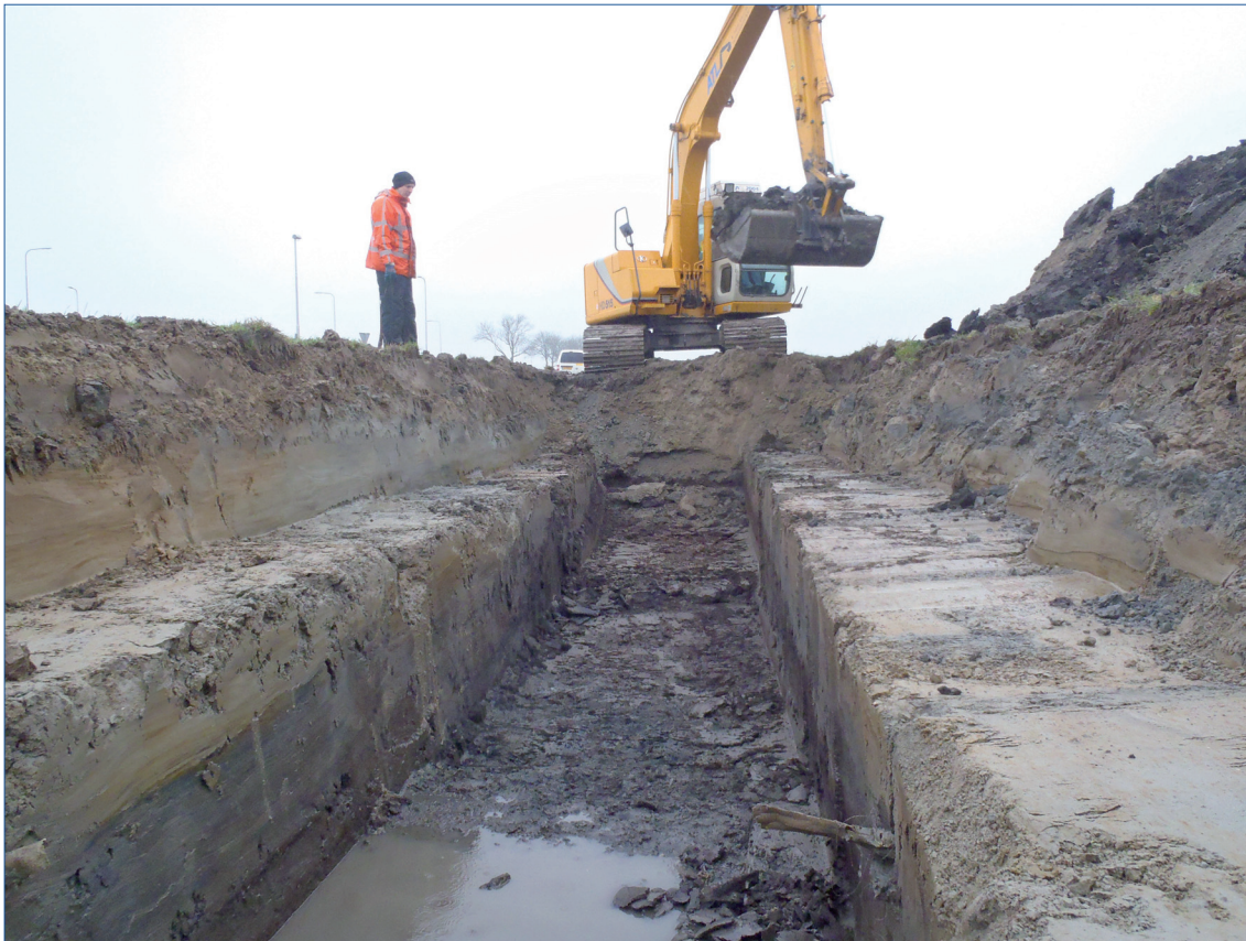
Figuur 2. Overzicht van de werkzaamheden. De getrapte aanleg van de proefsleuf is hierop duidelijk te zien.
