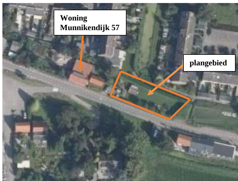
Figuur 1.2 plangebied met bebouwing
