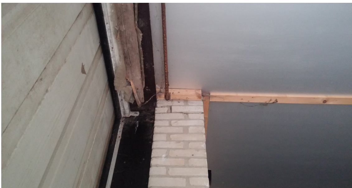
Figuur 3 Schuur Westdijk 89a binnenzijde
