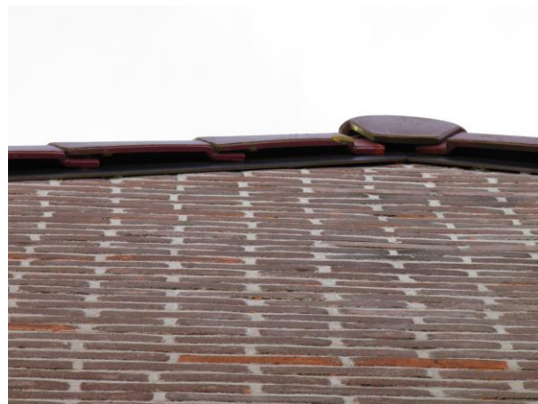
Figuur 5. De ruimte onder de dakpannen op de kopgevels kan net voldoende toegang geven voor een Gierzwaluw of Gewone Dwergvleermuis.
