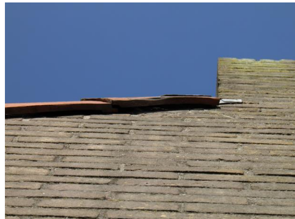
Figuur 11. Tussen de dakpanrand en de muur is een spleet waar vleermuizen tussen kunnen kruipen.
