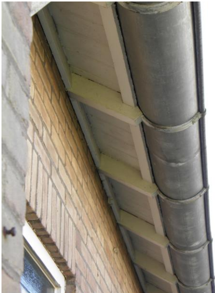
Figuur 8. Het houtwerk langs de dakgoot sluit naadloos aan op de buitenmuur aan het woonblok van Nieuw Weverseinde.
