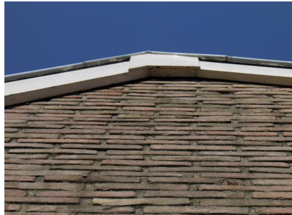
Figuur 9. Tussen de daklijst en de buitenmuur aan de kopgevel van de Paulus Potterstraat zit een smalle opening.
