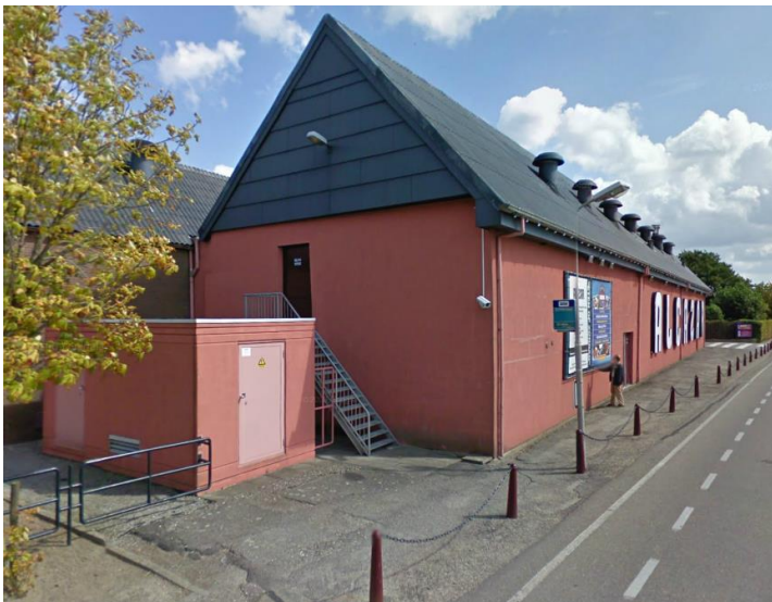
Figuur 4 bestaande horecabebouwing
