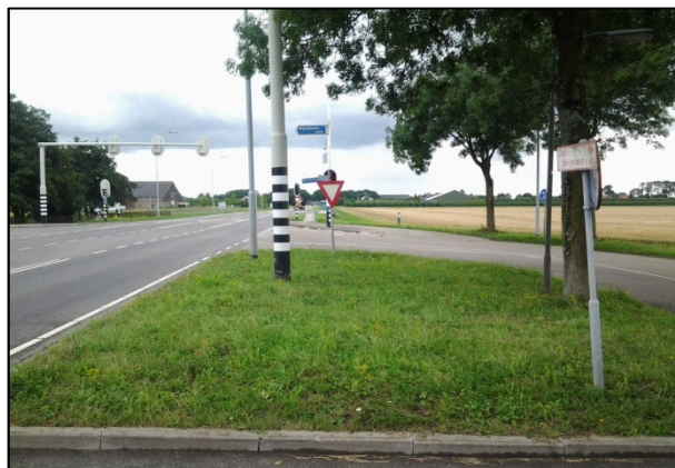
Foto 2: Onderzoekslocatie in zuidelijke richting.
