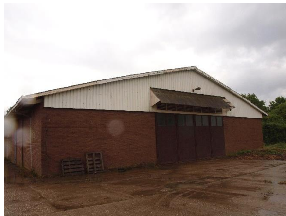
Figuur 3. Achterzijde van het koelhuis vanuit zuidelijke richting.
