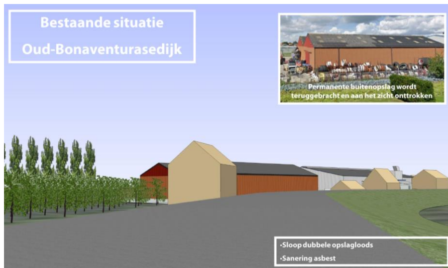
Zicht vanaf de Oud-Bonaventurasedijk in de bestaande situatie
