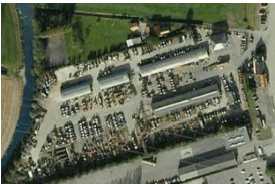
Figuur 4 luchtfoto bedrijfscomplex met te slopen gebouwen
